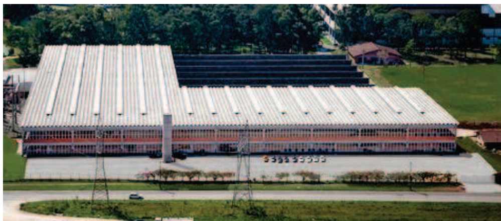
Visão Externa da Unidade de Fundição de Alumínio
