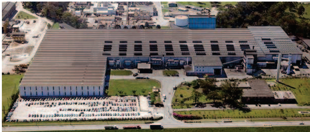
Visão Externa da Unidade de Fundição de Ferro
