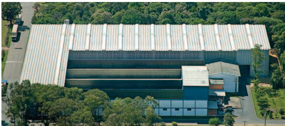
Visão Externa da Unidade de Forjaria
